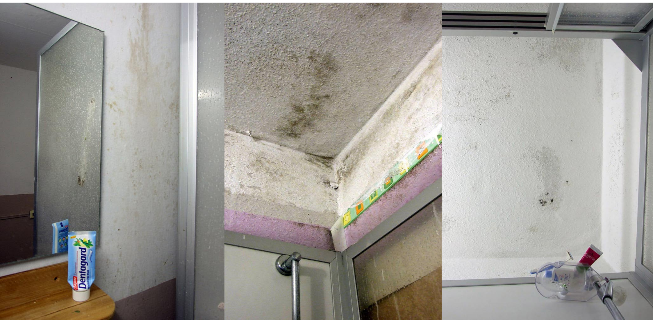
Schimmelbefall der Wände und Decken in verschiedenen Bädern
