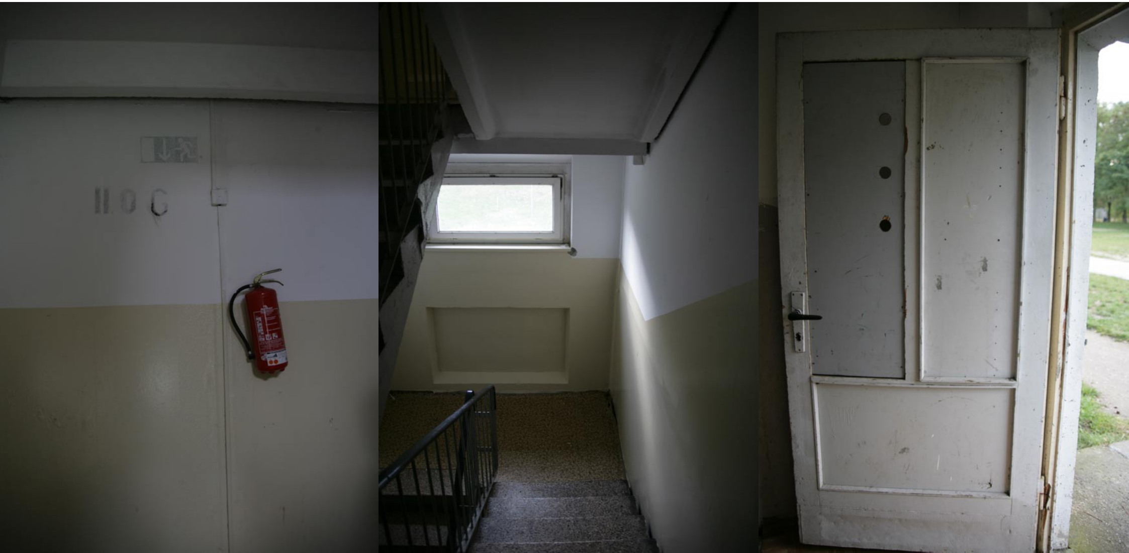
Hausflur nach Malerarbeiten im Herbst 2009 | Haustür
